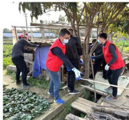
▲华宏集团支部党员志愿者们参加“文明创建”戴巷头专项行动，对部分棚舍进行了拆除整治
